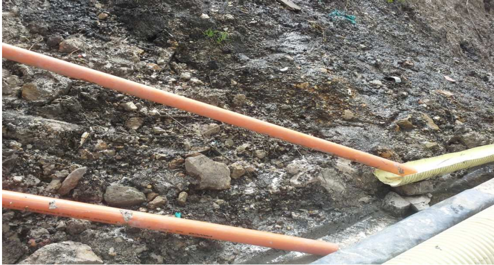
Foto No. 4 Rincón de Bolonia de la constructora CG constructores S.A.S
