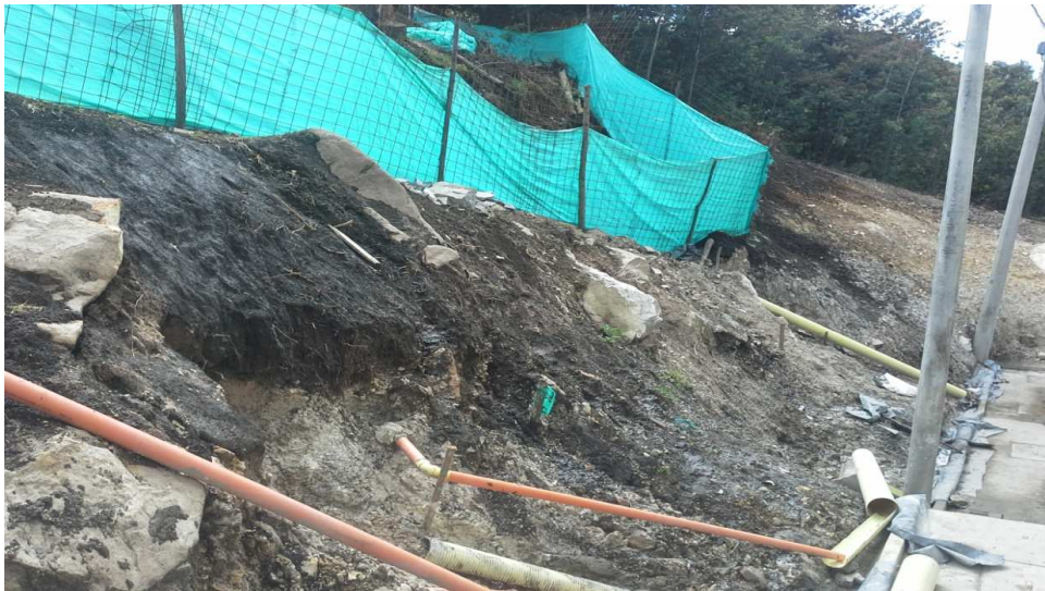
Foto No. 1 Rincón de Bolonia de la constructora CG constructores S.A.S
