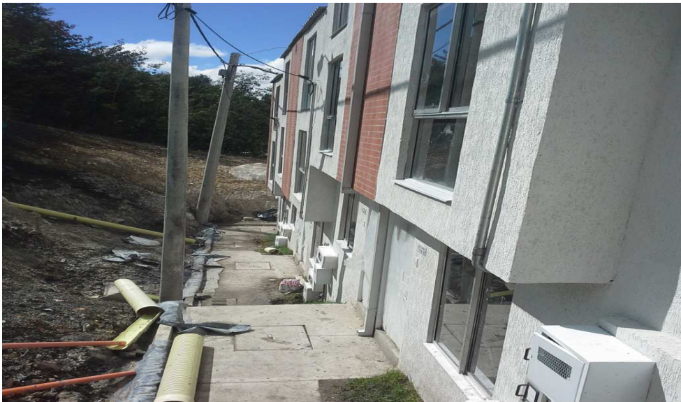
Foto No. 3 Rincón de Bolonia de la constructora CG constructores S.A.S
