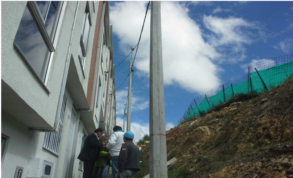
Foto No. 5 Rincón de Bolonia de la constructora CG constructores S.A.S
